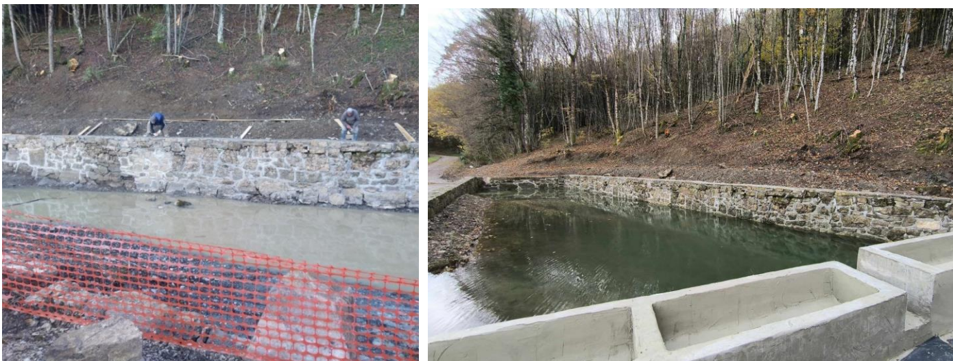
Slika 2: Potek obnove zidanega kala
