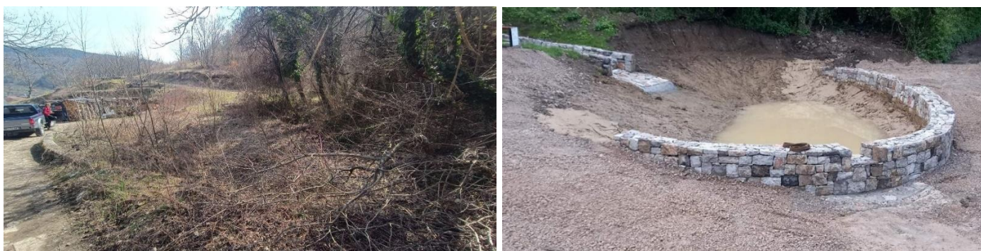
Slika 1: Stanje kala v Narinu pred obnovo in po obnovi marca 2024
