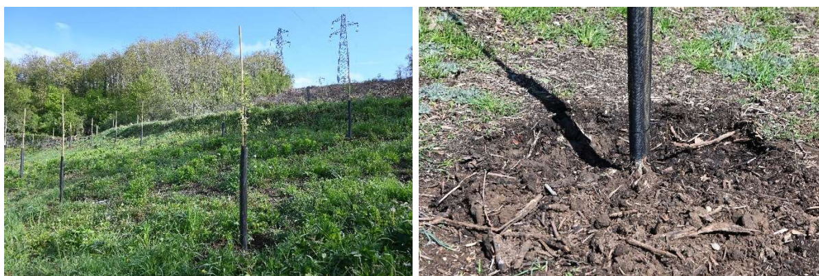
Slika 6 Sadike po obrezovanju na levi in zalivalne jame na desni.
